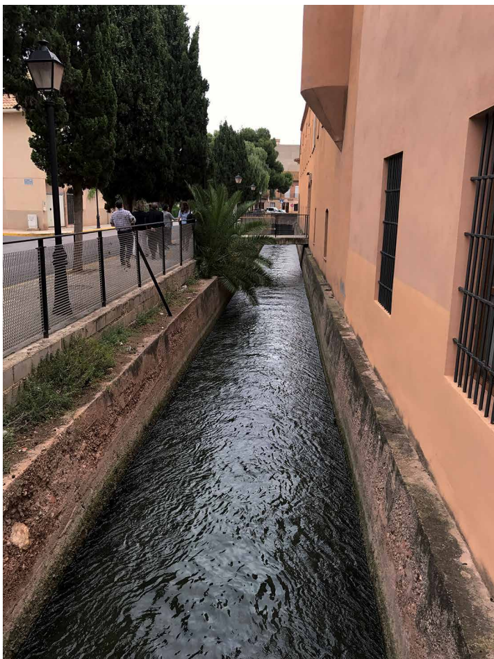
Acequia Moncada. Vinalosa
